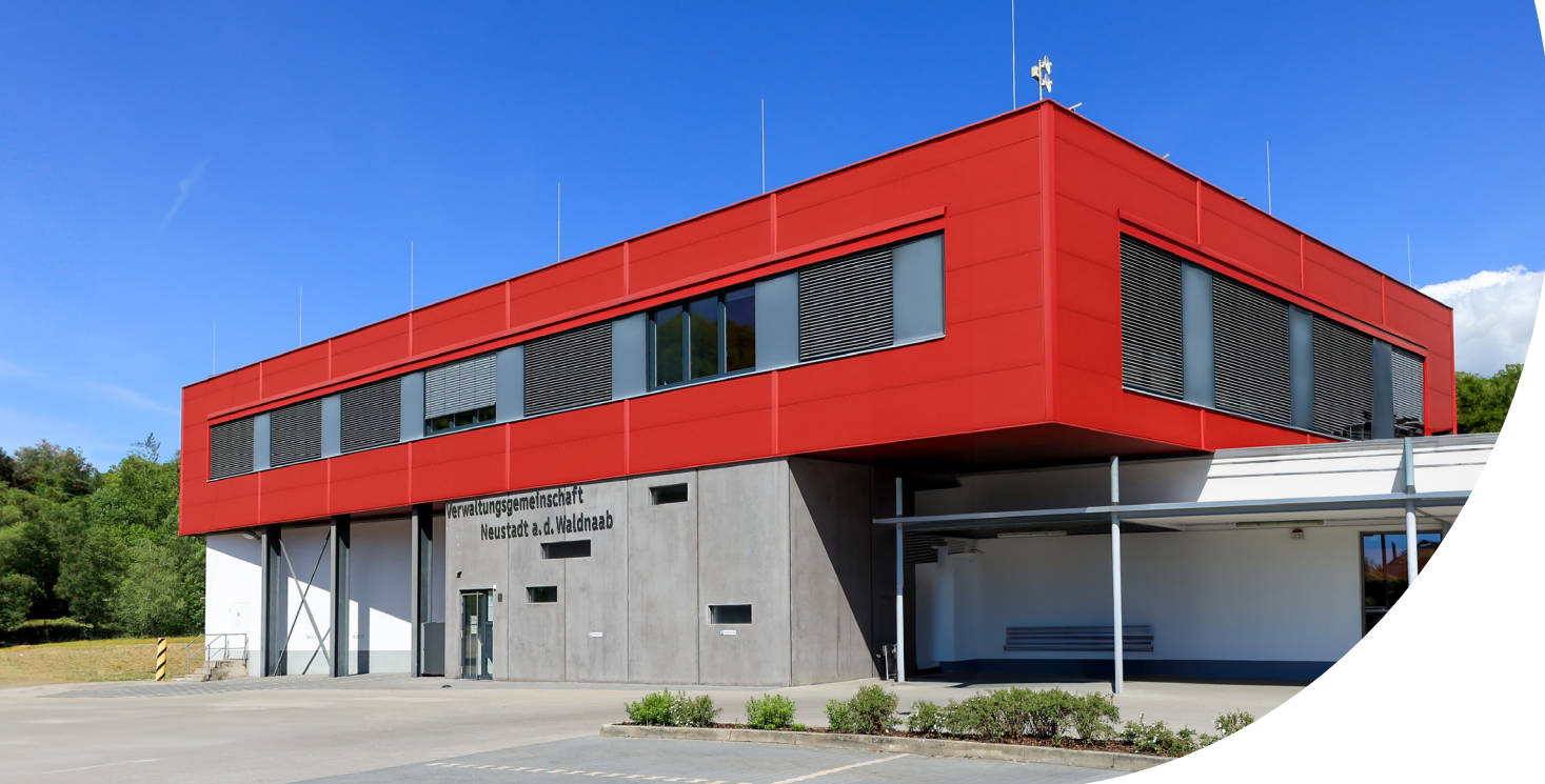
So zeigt sich heute das 2. Neustädter „Rathaus“ – die Geschäftsstelle der Verwaltungsgemeinschaft. Behindertengerecht, alle Räume auf einer Ebene. Sitzungssaal und Trauzimmer des Standesamts inbegriffen.
